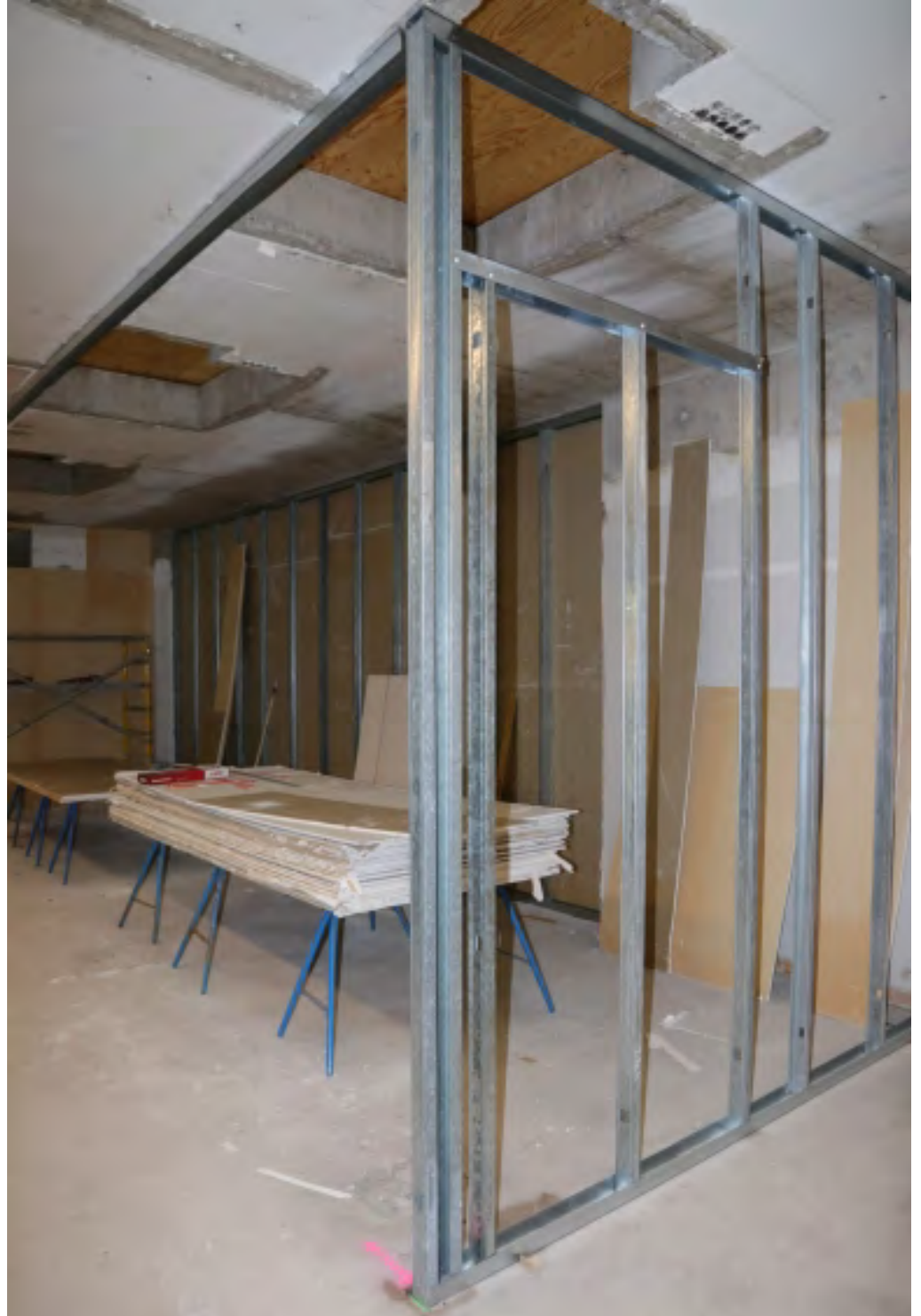
Gamla stålreglar: Lumi – modernt återbruk. Gamla stålreglar från 70-talet uppregraderade till nya innerväggar i väntan på att de gamla gipsskivorna skruvas fast igen.
