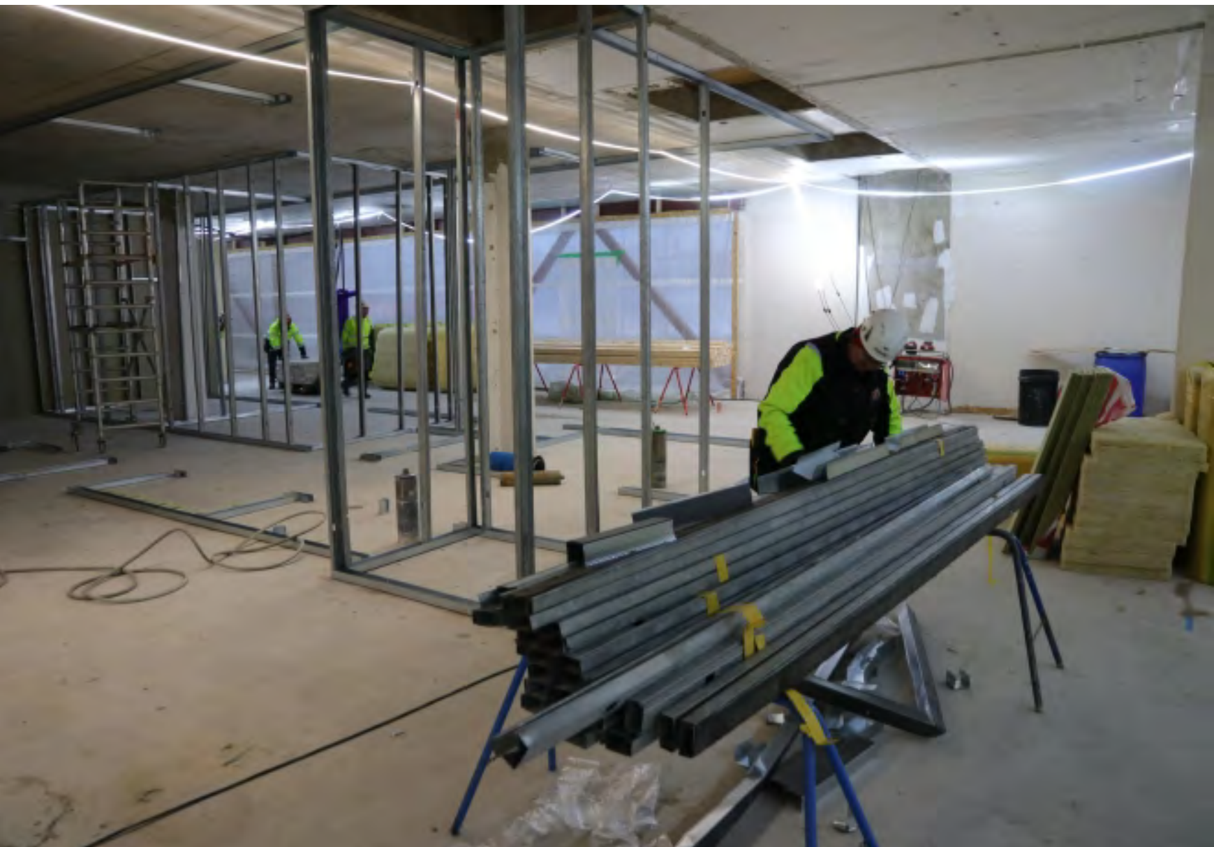
Ståltreklar återbruk: Lumi – modernt återbruk. Ståltreklarna återanvänds och blir som nya.
